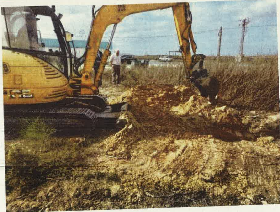
EXCAVADORA ABRIENDO CALICATA 2
